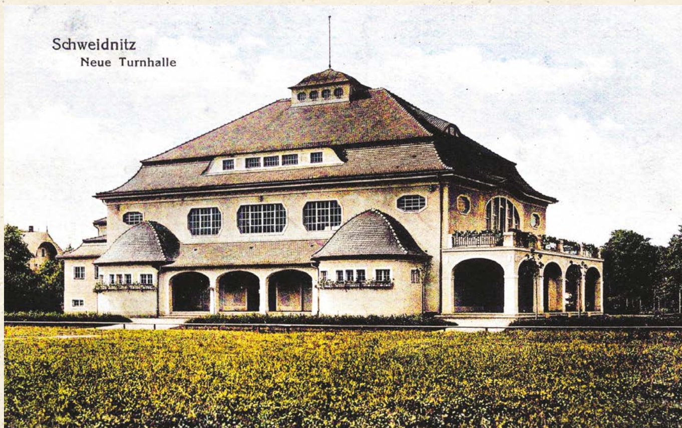
▲ Hala sportowa, dawna Hindenburg Turnhalle. Niestety, efektowne arkady wejścia głównego i taras nad nimi się znajdujące zostały w czasach powojennych zamurowane
