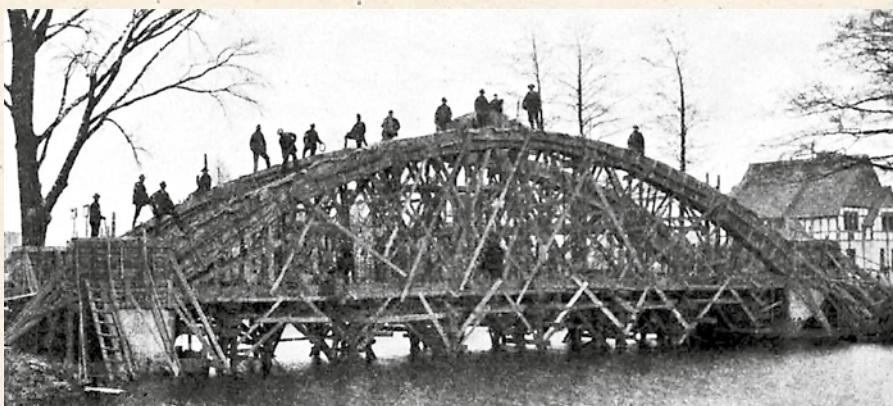
▲ Zdjęcie z okresu budowy mostu, zapewne na krótko przed betonowaniem. Widoczne są już drewniane szalunki zbrojenia
